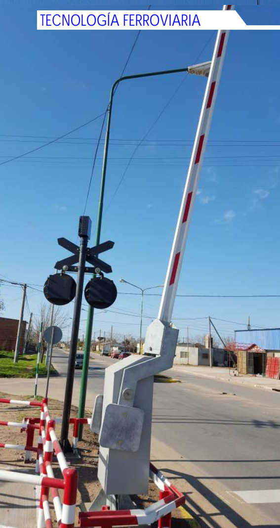
Arriba: Prueba realizada en un PAN de Junin. Derecha: Equipo de barrera automática en funcionamiento.
